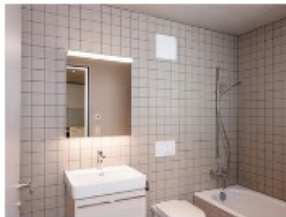
Fertiger Einbau in der Überbauung Cosmos in Dübendorf
