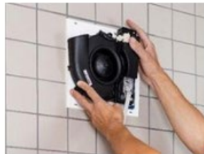
Einbau des Ventilators
