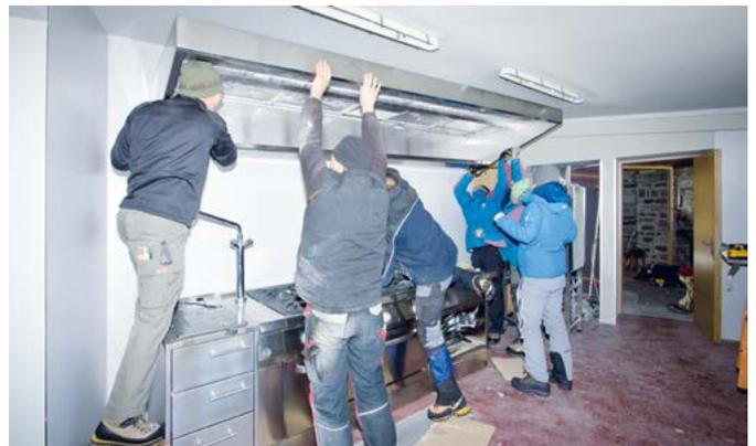
Die Installation erfolgte dank der guten Vorarbeit beider Firmen reibungslos. Mit vereinten Kräften wurde die Gastrohaube bei einer Umgebungstemperatur von 0 Grad über dem Herdblock montiert.
